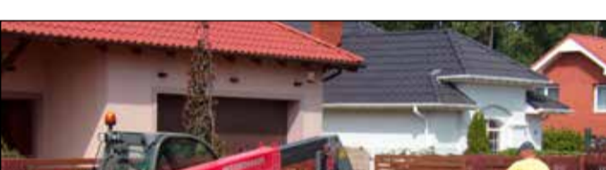
Rozpoczęcie budowy ulic Wrzosowej i Konwaliowej
