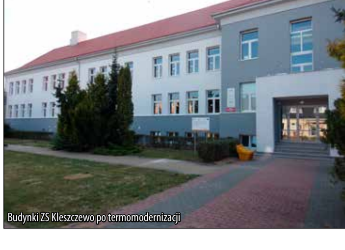
Budynki ZS Kleszczewo po termomodernizacji
